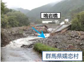
豪雨による落橋及び道路崩壊
