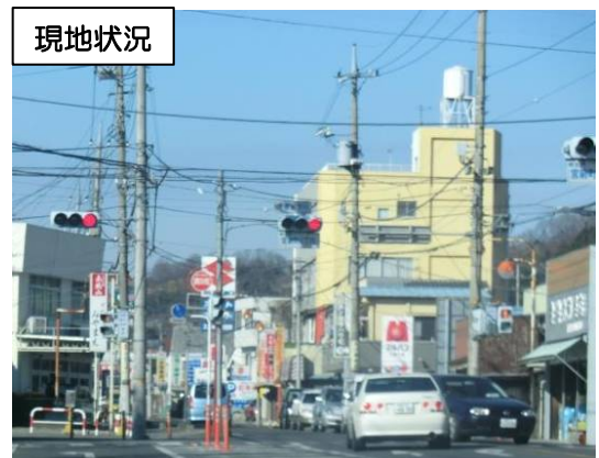
乱立する電柱・電線類
