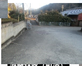
避難経路（町道）
