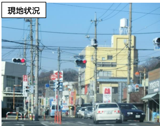
乱立する電柱・電線類
