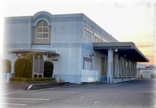
群馬県地域防災センター (大規模災害時の防災拠点)
