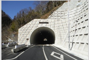
(国) 299号 上野村檜原地内 砥根平トンネル (H30完成)
