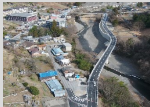
(国) 299号 神流町神ヶ原地内 古鉄橋上流工区 (R5完成)
