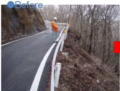
道路下斜面の崩壊を防止するため、擁壁を設置しました。
