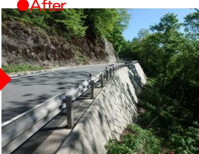
道路下斜面の崩壊を防止するため、擁壁を設置しました。
