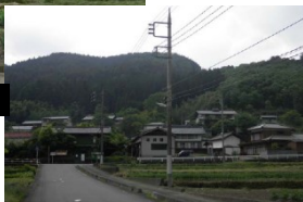
避難経路 (町道)
