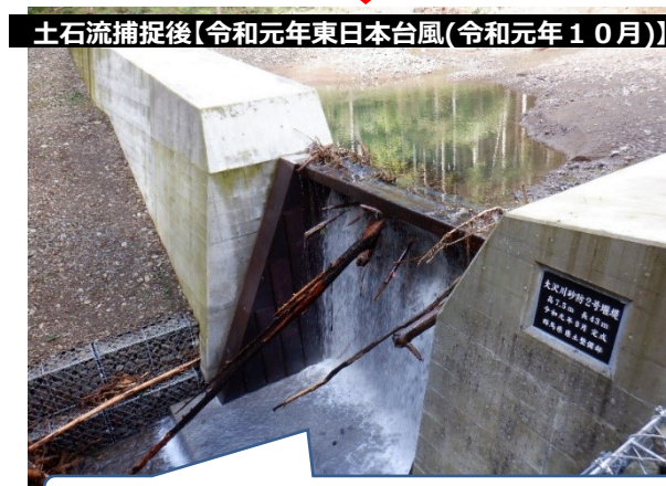
堰堤完成からわずか1ヶ月後に土石流を捕捉
