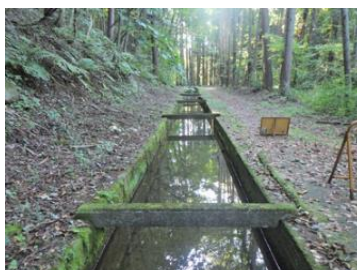
事業実施前（開水路）
