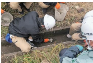
高校生による水路目地補修
