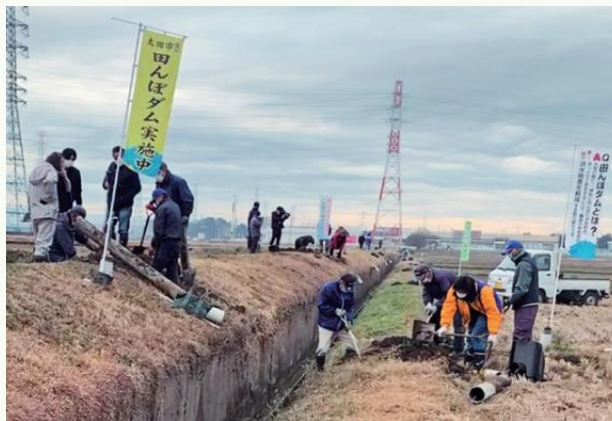
大学生と連携した田んぼダムの取組 (太田市：寺井地区)
