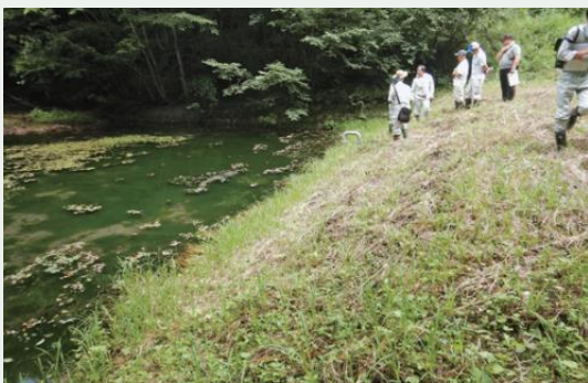
ため池サポートセンターぐんまによる現地パトロール
