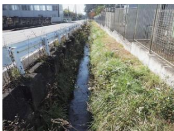
事業実施前（石積水路）
