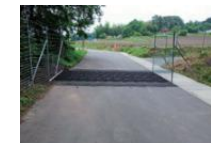
獣害防止柵及び獣害対策グレーチング
