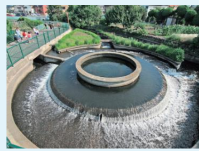
円筒分水工（長野堰用水）
