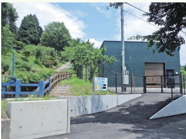
美野原小水力発電所（中之条町）
