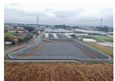
事業実施後（調整池整備）
