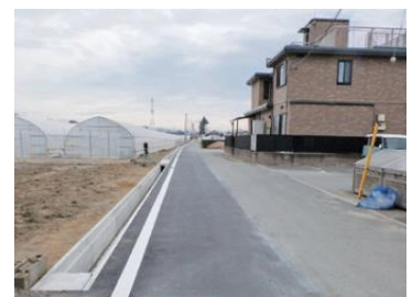
事業実施後（排水路整備）
