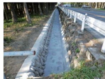
事業実施後（石積水路）
