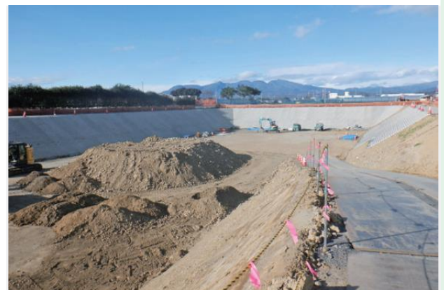
湛水被害を未然に防ぐ調整池の造成状況（太田市：藪塚西部地区）
