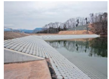
事業実施後（池田ため池内）
