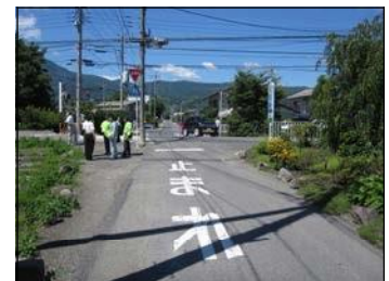
【事故危険箇所の合同点検】
