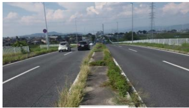
除草剤散布前
