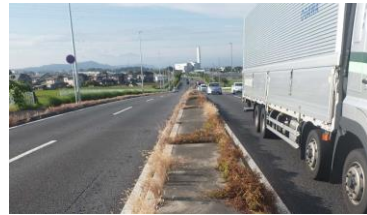
除草剤散布後
