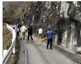
道路除草 実施状況
