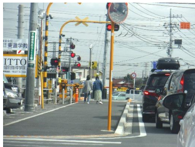
完了区間状況
