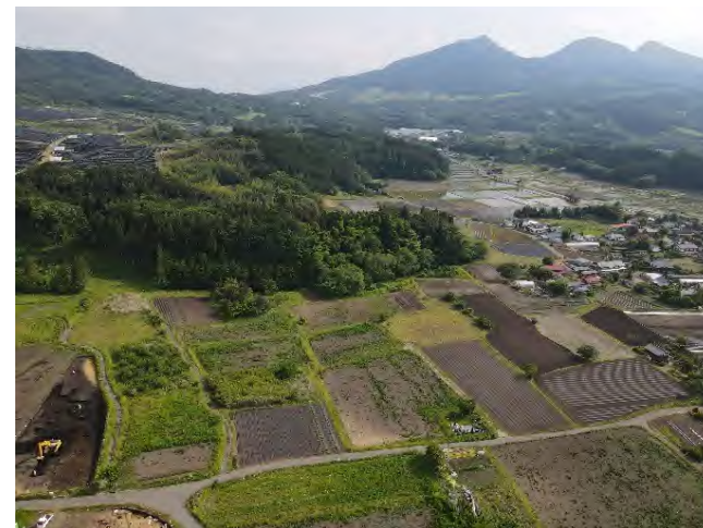
原地区 【区画整理工事着手前】
