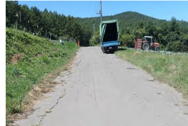
嬭恋西部地区 【農道路面補修着手前】
