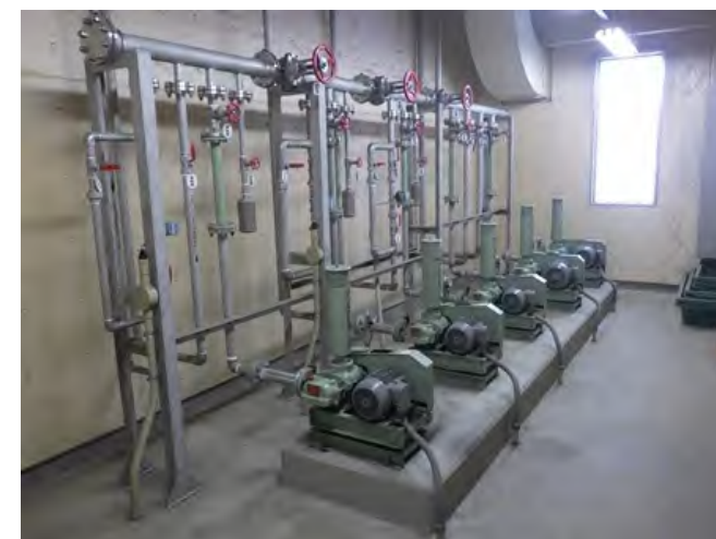
荒砥北部地区 【汚泥貯留槽施設改築前】
