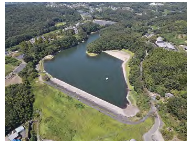
早川貯水池 【防災工事着手前】
