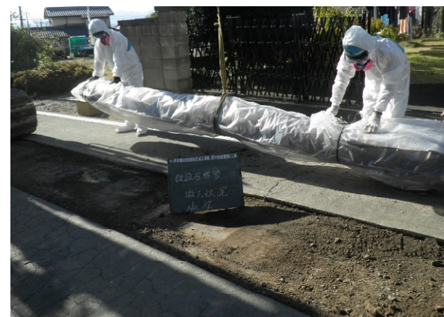
宮室原中地区 【石綿セメント管撤去状況】
