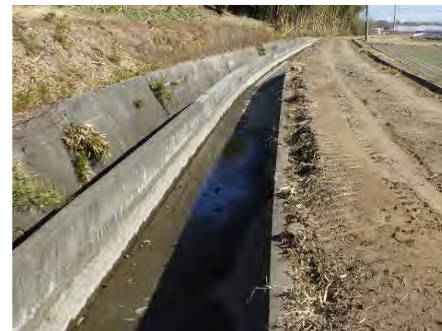
神流川用水地区 【長寿命化対策工事着手前】
