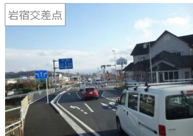
完了区間状況
