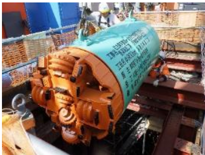
管渠整備 施工状況
