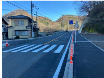
現道拡幅の整備状況
