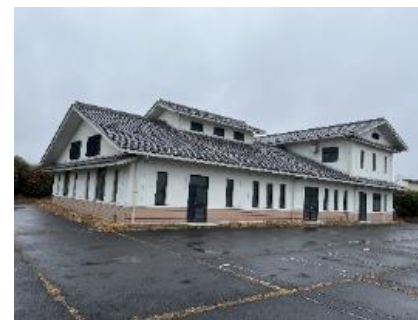
検討中の汚水処理施設
