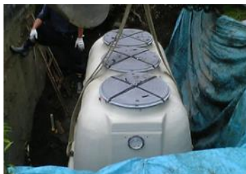
合併処理浄化槽 施工状況
