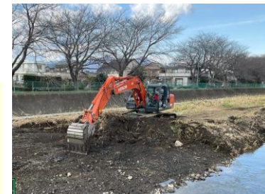
堆積土除去施工状況
