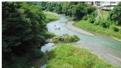
瀬と淵を保全した河川整備(神流川 神流町)
