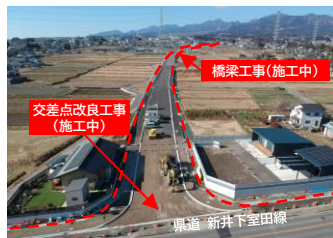
バイパス整備 施工状況
