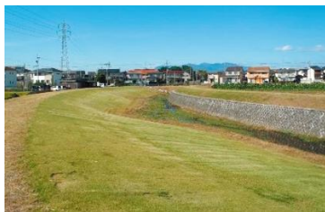
緩傾斜護岸(男井戸川 伊勢崎市)
