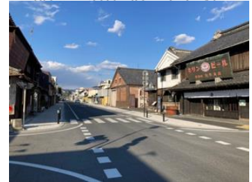
無電柱化事業の事例
