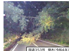
国道353号 倒木(令和4年) 整備前の状況
