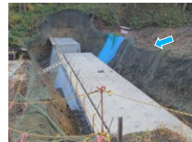
砂防堰堤の施工状況
