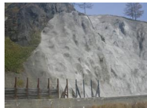
落石対策 施工中箇所
