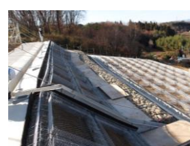
法枠工の施工状況
