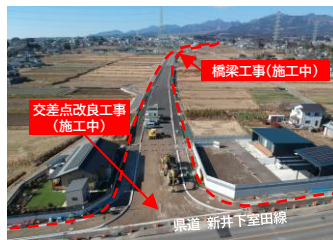
バイパス整備 施工状況
