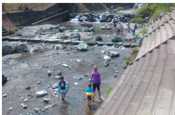
階段護岸(三波川 藤岡市)
