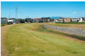
緩傾斜護岸(男井戸川 伊勢崎市)
