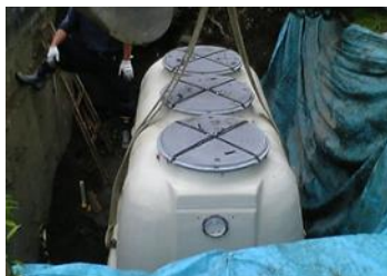
合併処理浄化槽 施工状況
