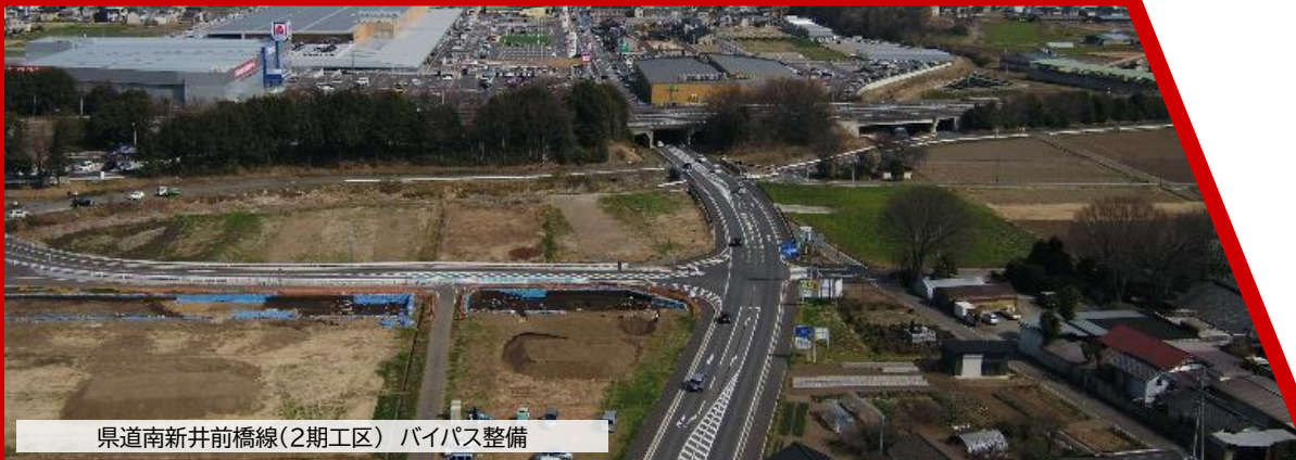
一級河川寺沢川 河川改修
