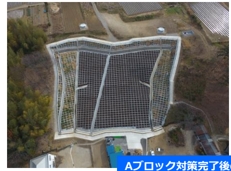
Aブロック対策完了後の状況
