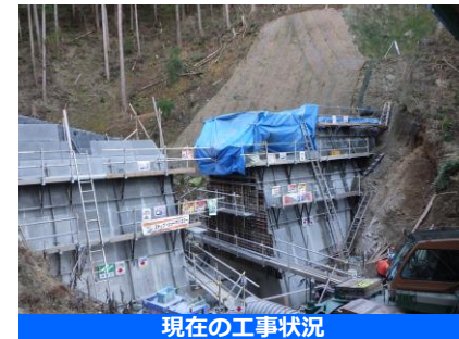
現在の工事状況
