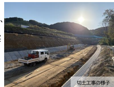
切土工事の様子
