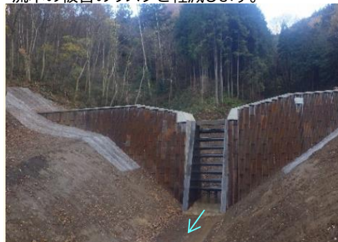
1号堰堤の完成状況
