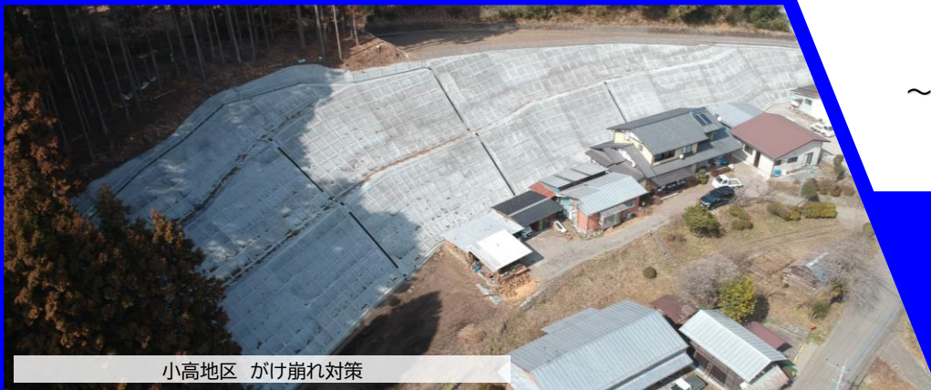
県道前橋長瀬線(綿貫工区) 現道拡幅
