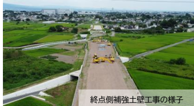
終点側補強土壁工事の様子
