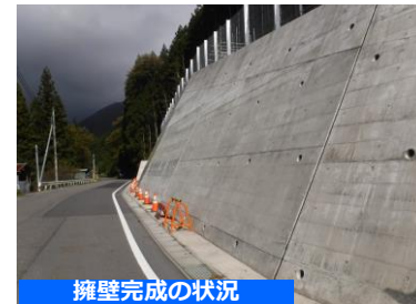
擁壁完成の状況
