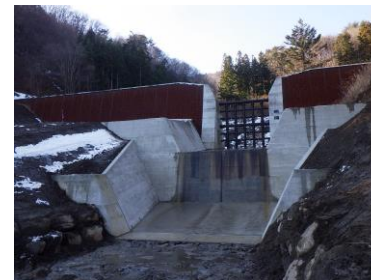
2号堰堤の状況
