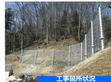
工事箇所状況
