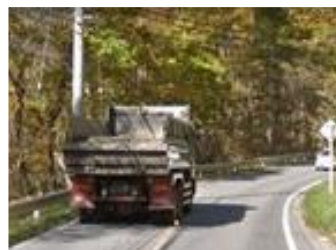
国道144号幅員狭小状況
