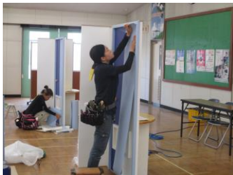
技能検定(内装仕上げ施工)
