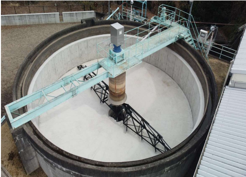
澁川工業用水道事務所 濃縮槽
