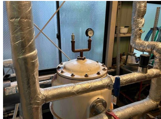
山中温泉の近世より続く老舗旅館「たわらや」の機械室（左がメイン、右がサブ）。左の写真の左端にある銀色のタンクと右の写真の真ん中のタンクが循環濾過槽。左の写真の左下のタンクに塩素が入っている。
