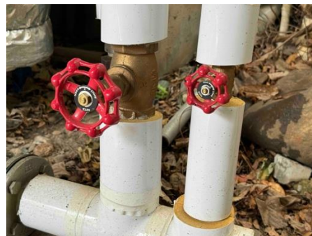
鳴子大沼旅館では自家源泉と共同源泉の湯を掛け流しで敷地内外の浴槽に使っている。左はその管理の装置で右はバルブ部分の拡大図。このバルブを、気温や天候を踏まえ、微妙に調整し、適温となる掛け流しを行う。
