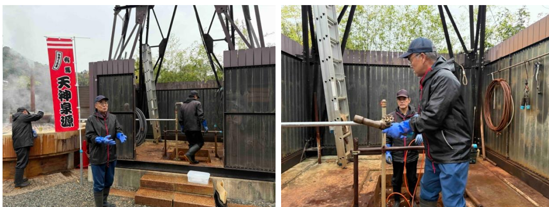
有馬温泉の天神泉源のメンテナンスの様子。スケールが極めて多いためケーシングをかなりの頻度で交換する必要があるが、交換作業は、高圧・高温の湯が噴き出してくるため、極めて危険であり、長年の経験に裏打ちされた感覚が必要とされる。
