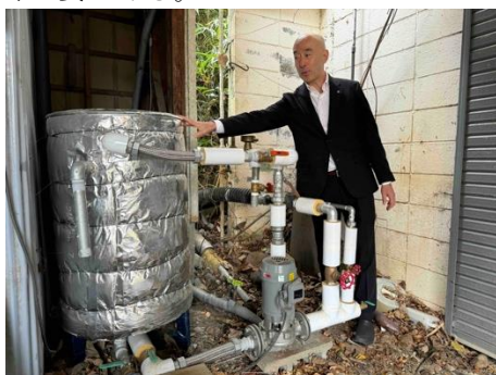
鳴子大沼旅館では自家源泉と共同源泉の湯を掛け流しで敷地内外の浴槽に使っている。左はその管理の装置で右はバルブ部分の拡大図。このバルブを、気温や天候を踏まえ、微妙に調整し、適温となる掛け流しを行う。
