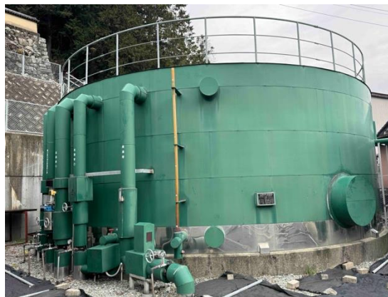
下呂温泉の集中管理システムを支える4つのポンプ所の一つ、温泉寺ポンプ所の貯湯タンク。ここから下呂温泉の各旅館へと送湯される。
