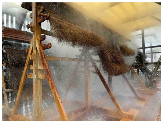
別府鉄輪温泉「ひょうたん温泉」で開発・使用している「湯雨竹」。100度から47度まで僅か数秒で下がる。
