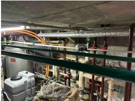
山中温泉の近世より続く老舗旅館「たわらや」の機械室（左がメイン、右がサブ）。左の写真の左端にある銀色のタンクと右の写真の真ん中のタンクが循環濾過槽。左の写真の左下のタンクに塩素が入っている。
