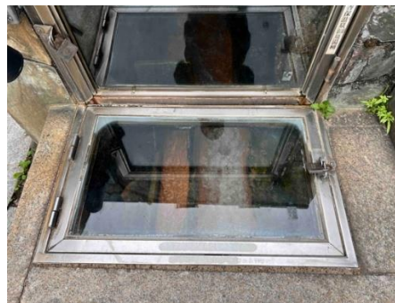
伊香保温泉の石段にある清掃口。下に温泉湯が引き湯されている樋が見える。
