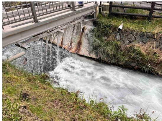
草津の中和工場で行われている川への石灰の投下。石灰の量については、pH を図りつつ人間が経験によって調整している。
