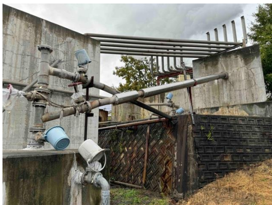
別府鉄輪温泉「ひょうたん温泉」のセパレーター。高圧の温泉が温泉水と蒸気に分離される。右上のパイプから、分離された蒸気の一部が湯けむりとして出てきてい
