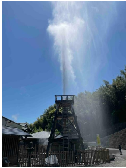
草津の万代鉱源泉の熱交換施設。温度が非常に高いだけでなく、酸性度も極めて高く、普通の材料では長く持たない。
