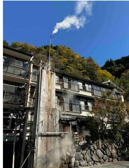
杖立温泉では100度の蒸気が噴き出ていることに加え、源泉の塩分濃度が高いため、パイプの腐食がすぐに進んでしまう。
