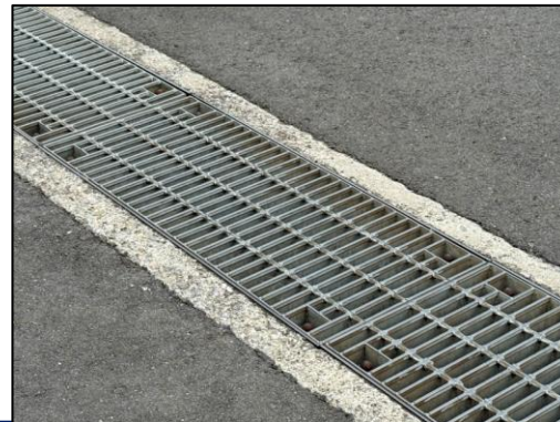
グレーチング (金属製のものに限る。)
