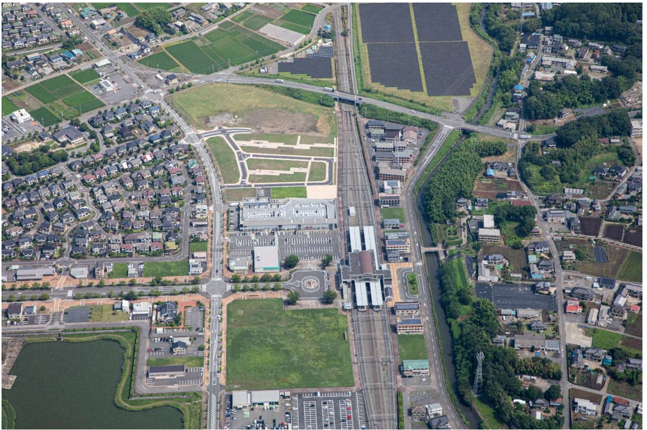
板倉ニュータウン グリーンブロック全景
