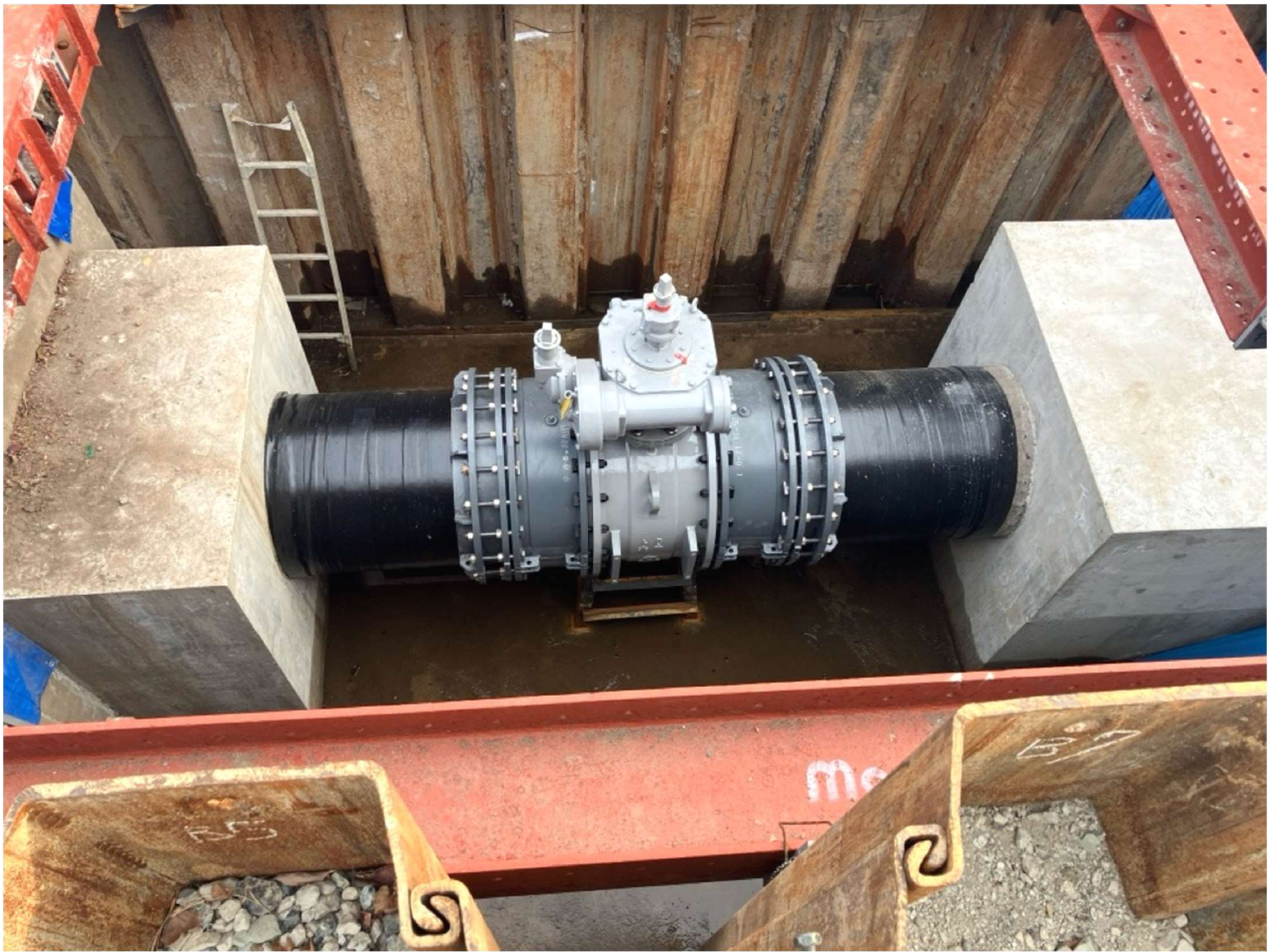
県央第一水道事務所 調整池流入管仕切弁設置 (φ800mm)
