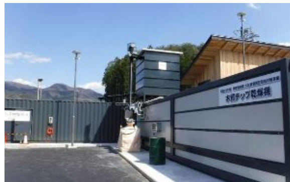
木質バイオマス発電所(川場村)
