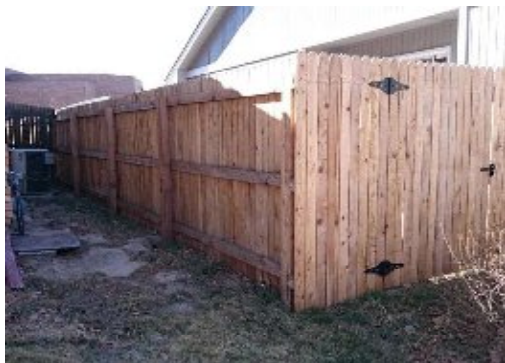
県産木材のツーバイフォー部材を使用したフェンス(例)
