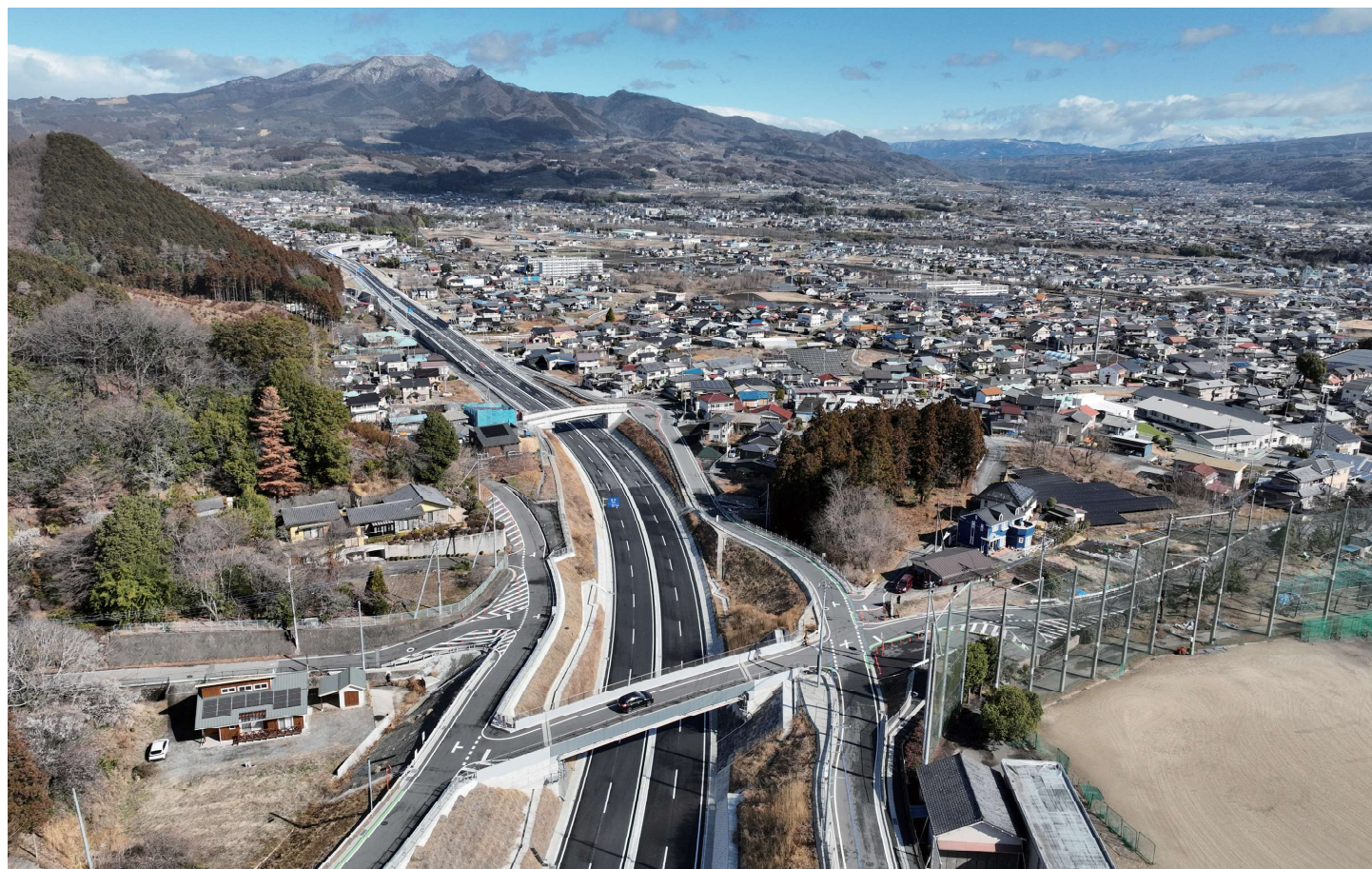
国道17号 渋川西バイパス空撮
