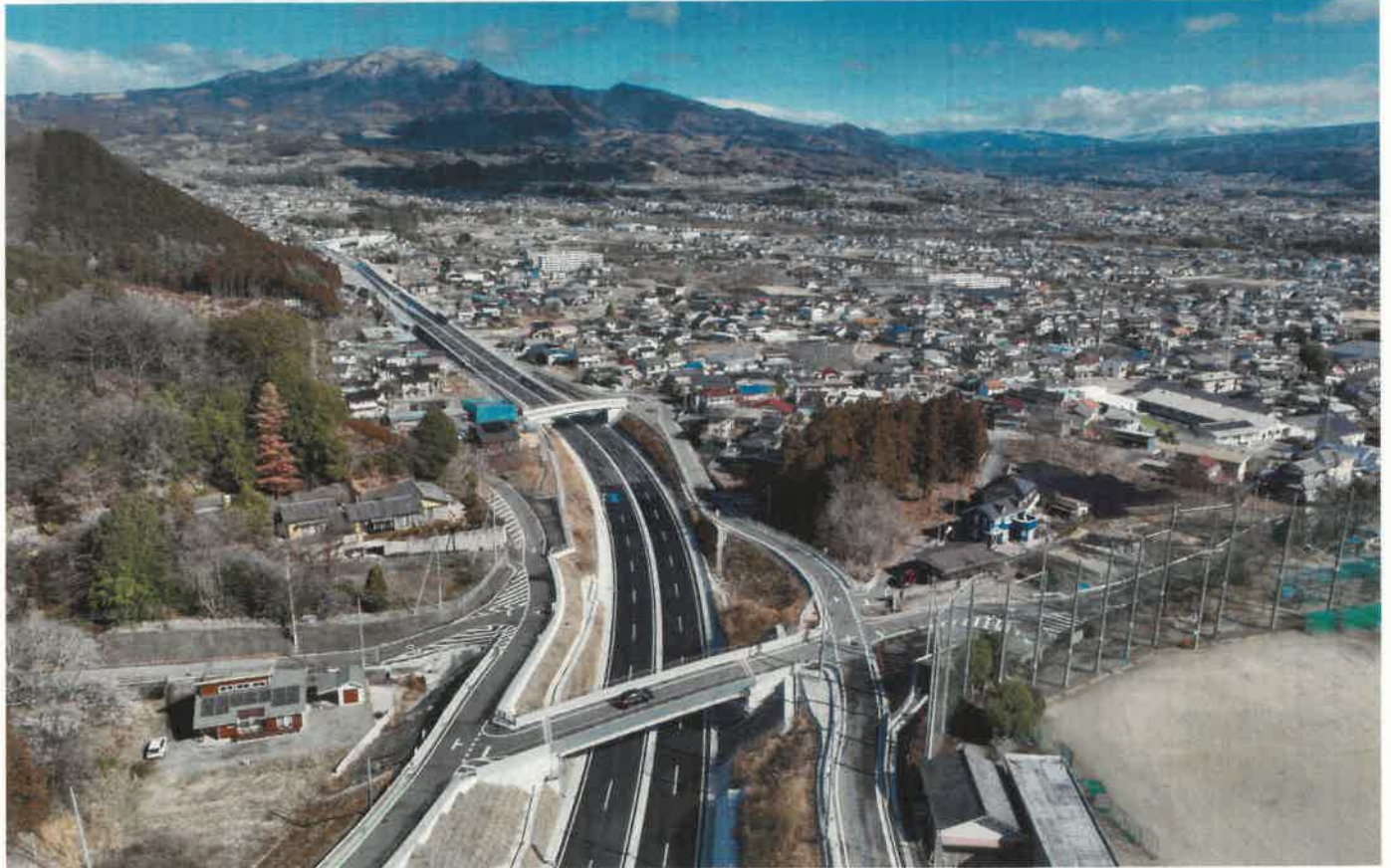
国道17号 渋川西バイパス空撮
