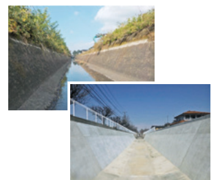
農業水利施設の保全対策
