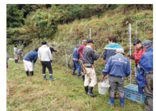
侵入防止柵の設置
