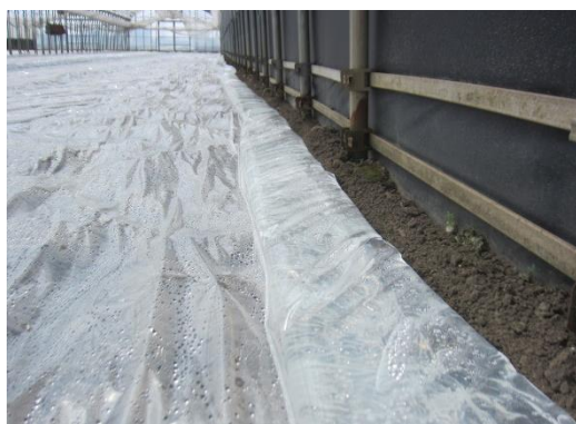
写真5-6 水封ダクトによる被覆の密閉
