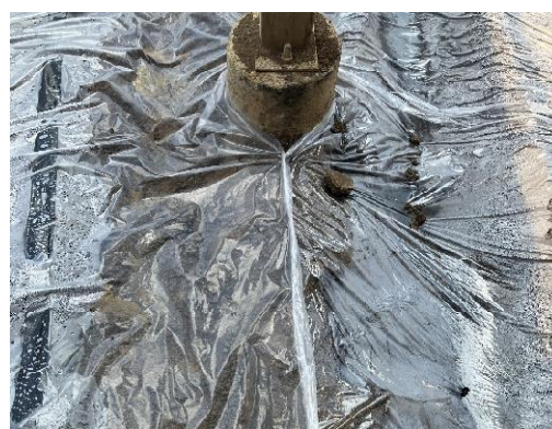
写真5-4 柱基部の被覆
