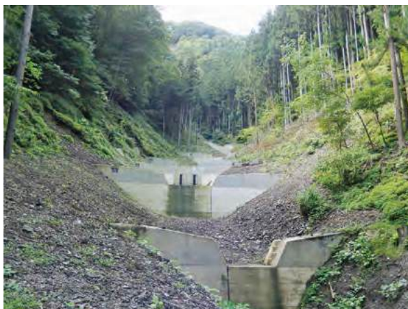
治山施設の設置（谷止工）
