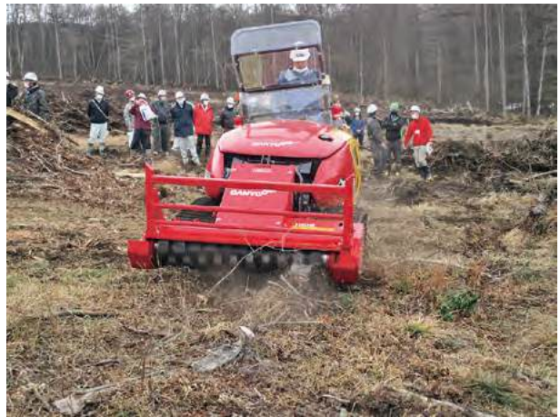
多目的造林機械による下刈作業
