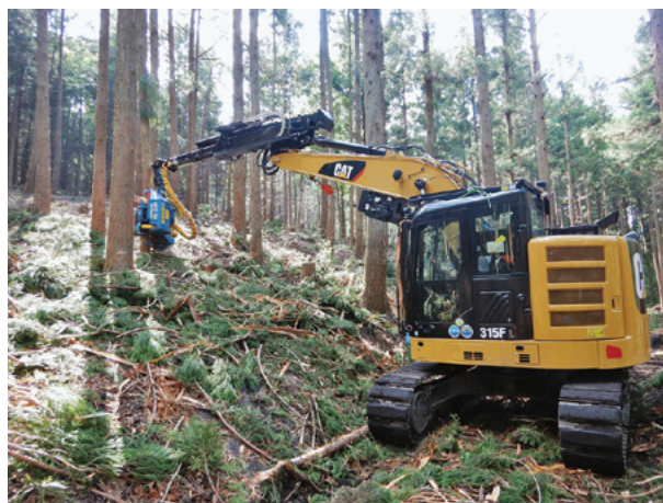
高性能林業機械による伐採作業
