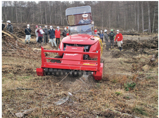
多目的造林機械による下刈作業
