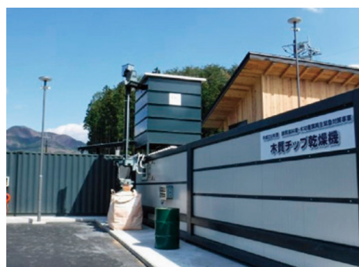
木質バイオマス発電所（川場村）
