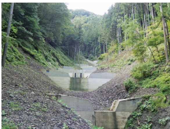
治山施設の設置（谷止工）
