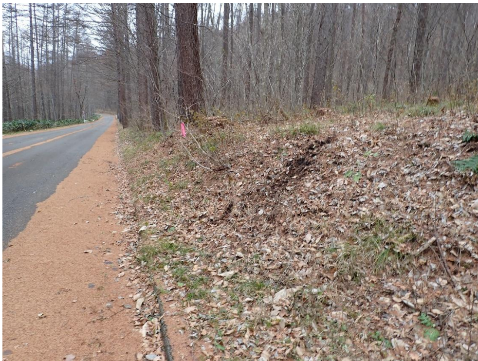
図 31 国道 401 号線の大清水の西側には、過年度と同じく複数の獣道ができていた （12 月 2 日撮影）
