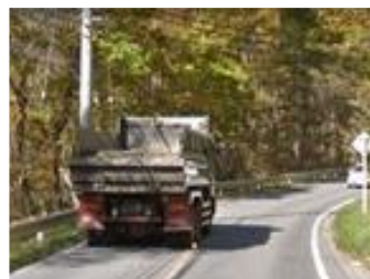
国道144号幅員狭小状況
