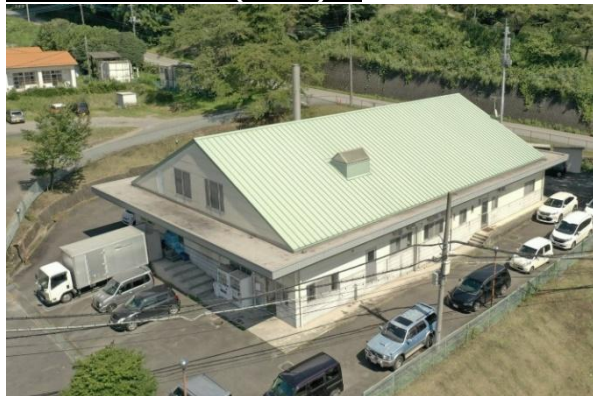
要配慮者利用施設(管理棟)
