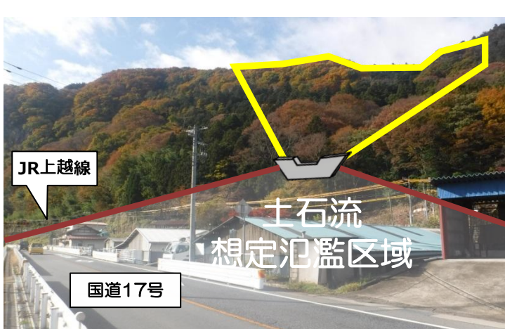
土石堆積状況
