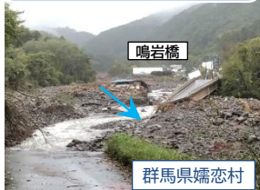
豪雨による落橋及び道路崩壊
