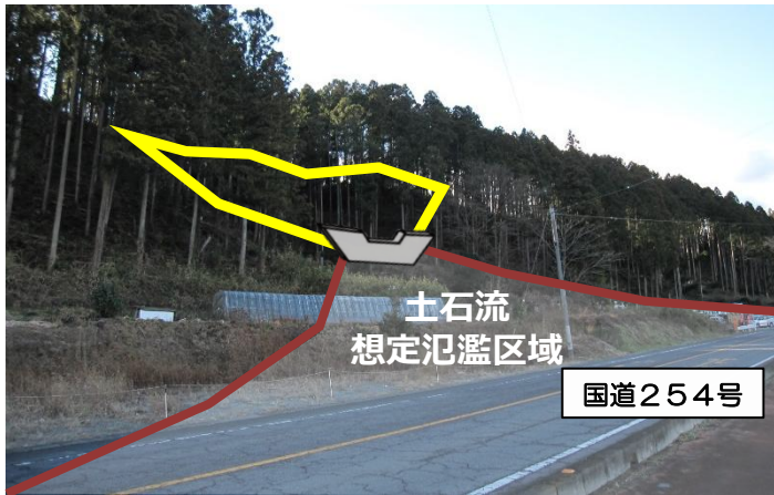
土石堆積状況
