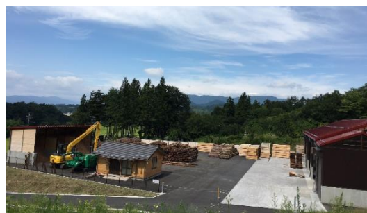
ウッドビレジ川場製材工場
