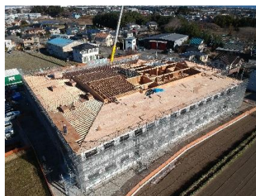
中大規模施設に県産木材を活用 (有料老人ホーム)
