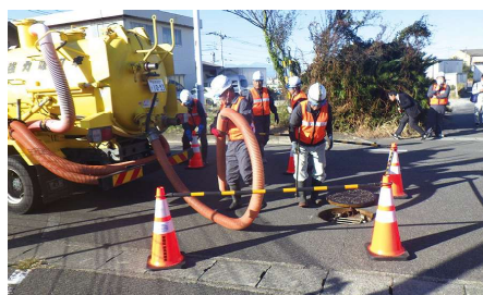
消防機関の要請を受け、管路管理業協会が強力吸引車による排水作業を実施
