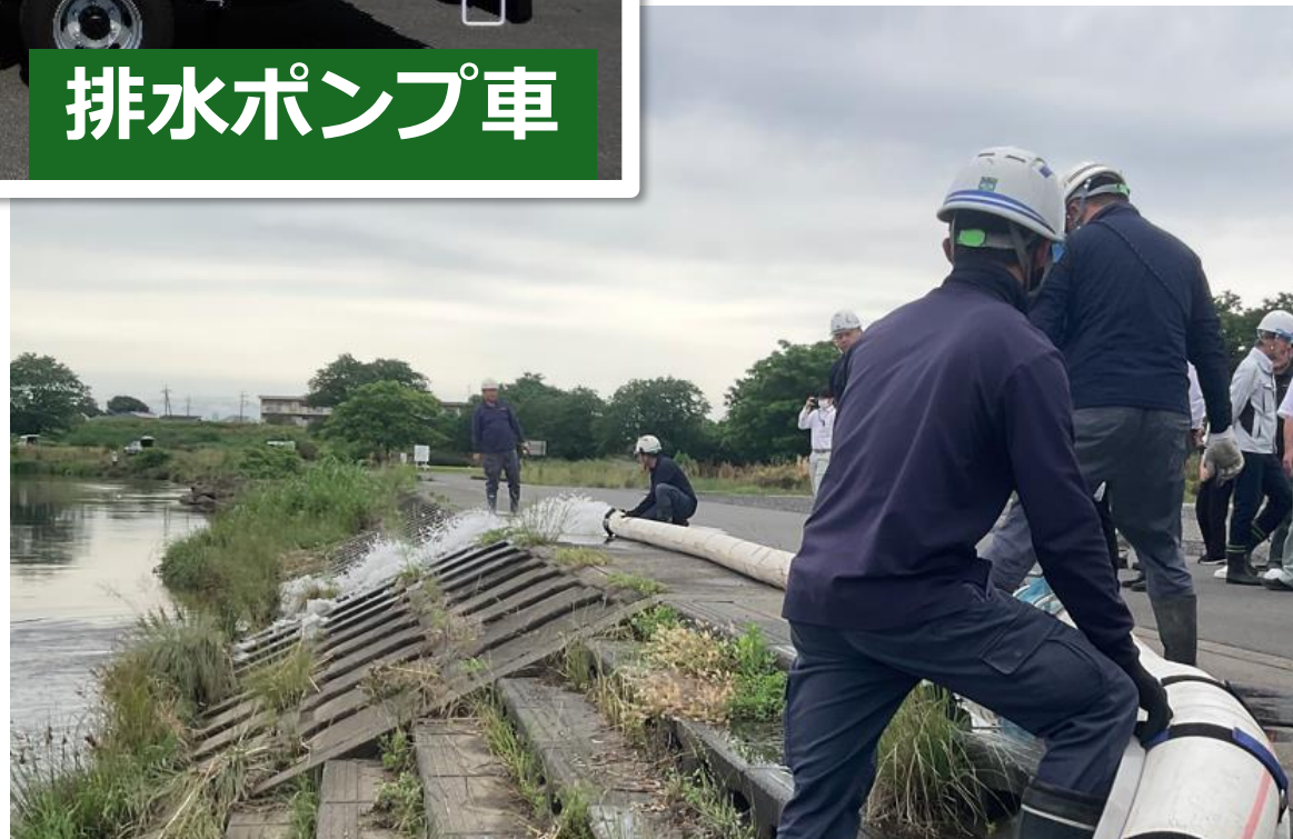
排水ポンプ車の操作訓練
