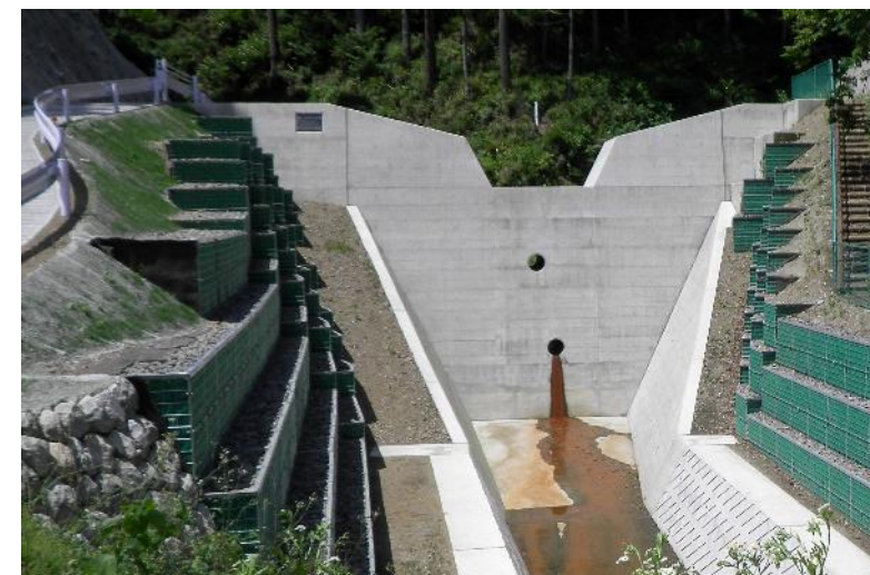
砂防堰堤整備
