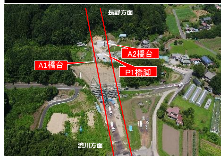
上信小泉橋 施工状況 (R8. 8撮影)
