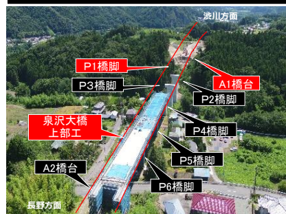
泉沢大橋 施工状況 (R8. 8撮影)
