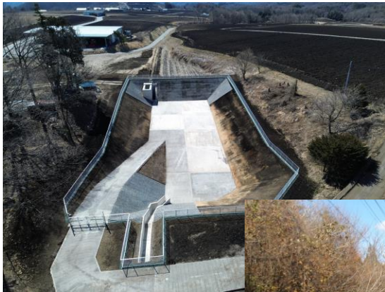
整備後の調整池 兼沈砂池 【仙之入地区】
