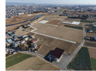
境小此木東部地区 【区画整理工事完了】
