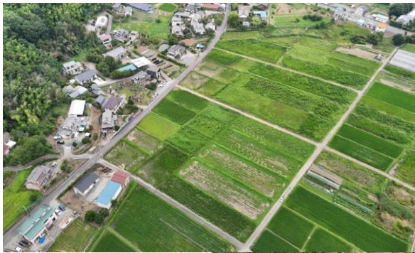
第 3 工区工事着手前
