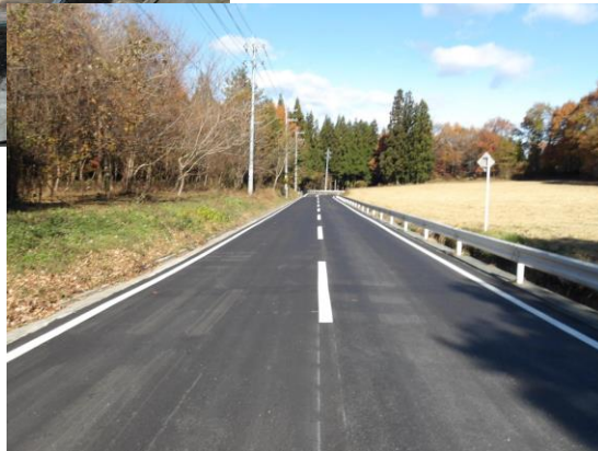
補修した農道 【榛名西麓 2 期地区】
