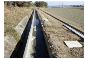
神流川用水地区 【既設水路改修後】
