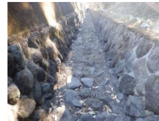
対策工事実施前
