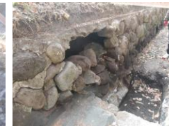
石積み護岸の崩落
