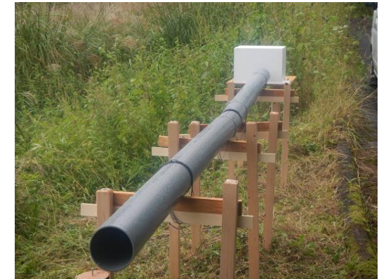
地表伸縮計設置状況
