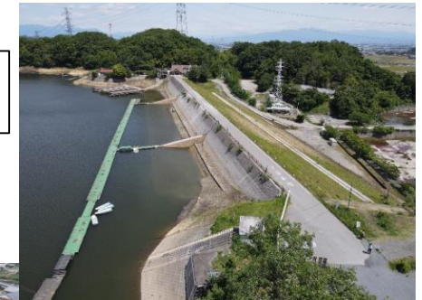
大谷池 (施工前の堤体上流側の状況)
