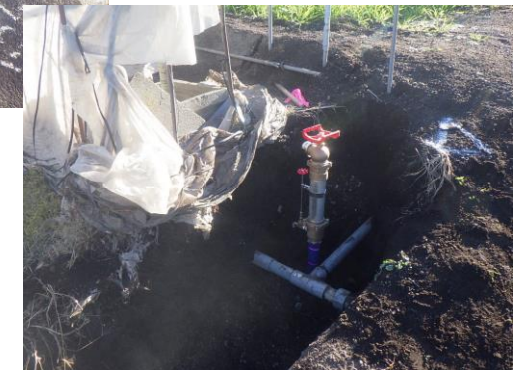
給水栓の布設
