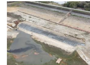
牛秣貯水池 【堤体上流側耐震補強 工事施工状況】
