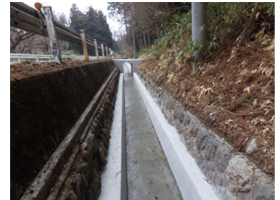
対策工事実施後
