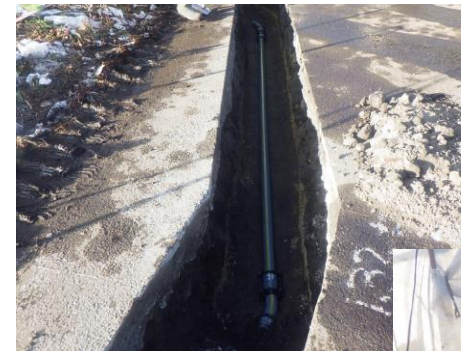
新設塩化ビニル管 の布設
