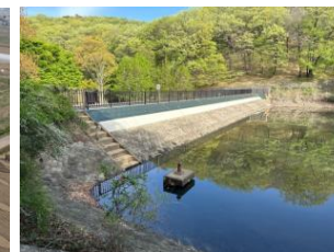
長手第1溜池地区 【対策工事実施】
