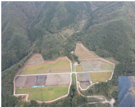
区画整理工事实施前 (上空から)
