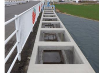
佐波新田用水第2地区 【対策工事後の水路】
