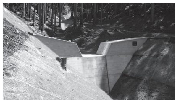
土砂流出の抑制のため施工された治山ダム工
