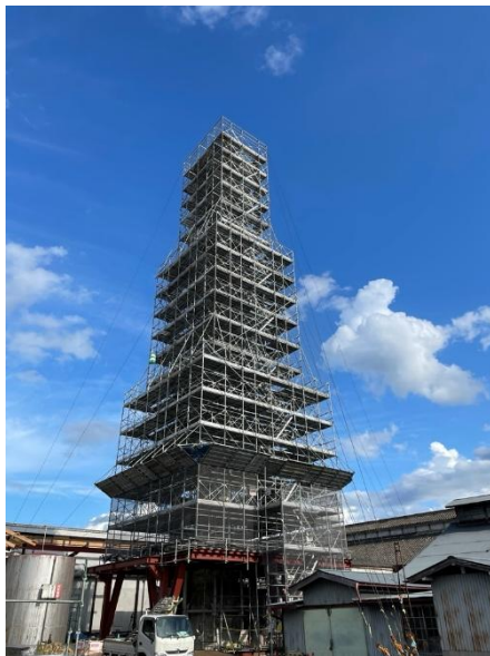
富岡製糸場煙突保存修理 (画像提供：富岡市)
