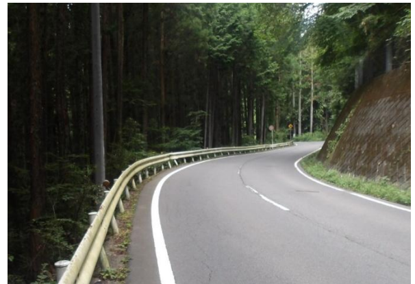
道路の除草状況（渋川松井田線）
