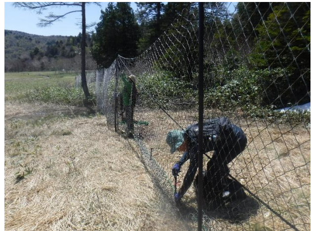
植生保護柵の設置
