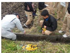
施設機能診断
