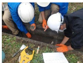
水路簡易補修
