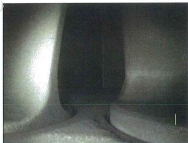
写真(11) ボアスコープポート#23より 圧縮機6段静翼外端
