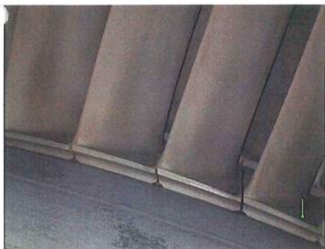
写真(33) ボアスコープポート#10Dより 高圧タービン2段動翼内端
