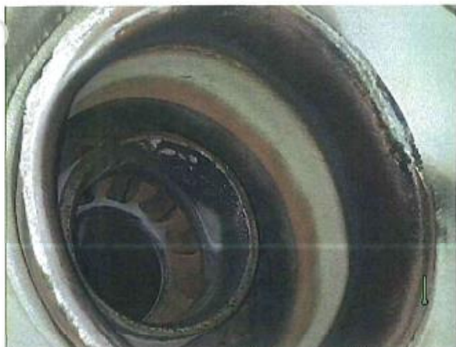
写真(19) ボアスコープポート#13Bより 燃焼器トランペットエリア部
