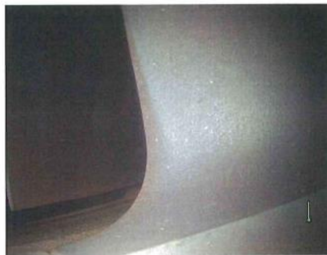
写真(16) ボアスコープポート#14より 圧縮機15段静翼外端
