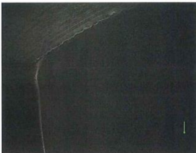
写真(10) ボアスコープポート#23より 圧縮機6段動翼内端
