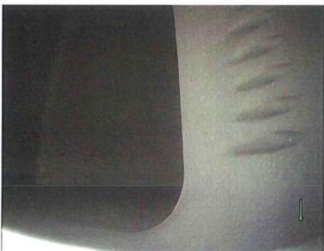
写真(30) ボアスコープポート#11より 高圧タービン2段静翼外端
