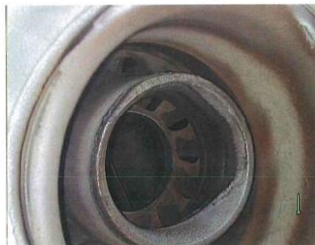
写真(18) ボアスコープポート#13Bより 燃焼器トランペットエリア部
