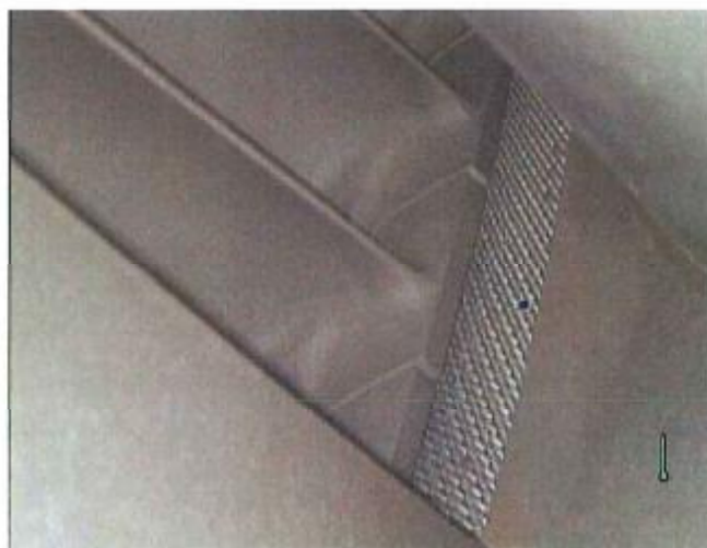
写真(36) ボアスコープポート#10Dより 低圧タービン1段動翼外端
