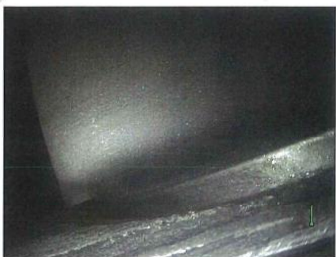
写真(5) ボアスコープポート#28より 圧縮機1段静翼外端
