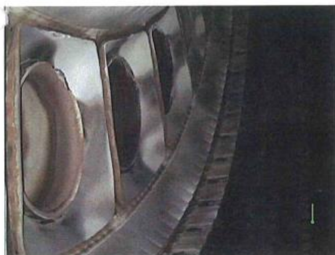
写真(21) 燃料ノズル取外し箇所より 燃焼器点検状況(上流側)
