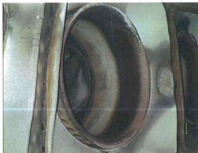
写真(20) ボアスコープポート#13Bより 燃焼器トランペットエリア部
