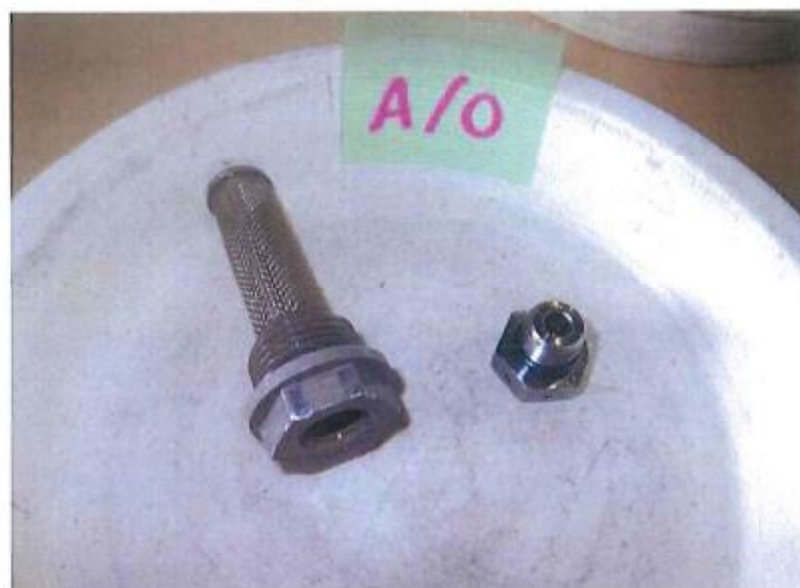
位置: 機械室 撮影日: 平成22年10月13日
