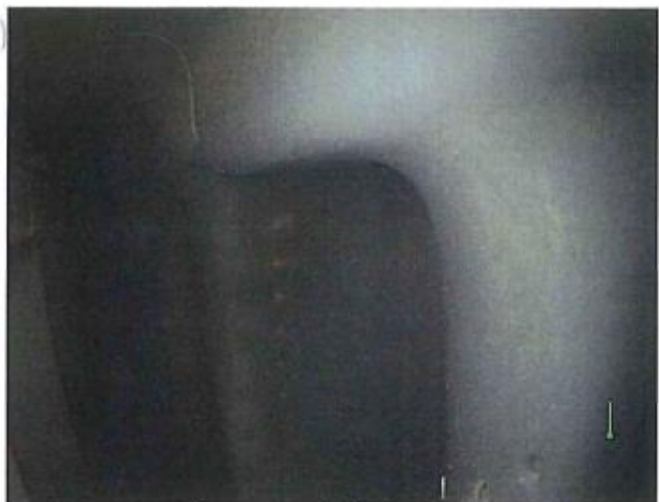
写真(27) ボアスコープポート#12より 高圧タービン1段動翼内端
