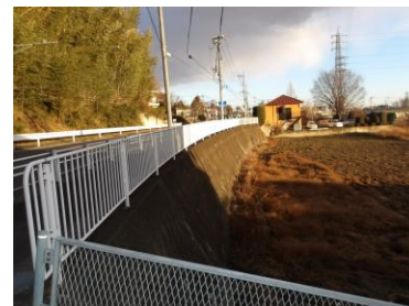
R7道路改良工事予定箇所
