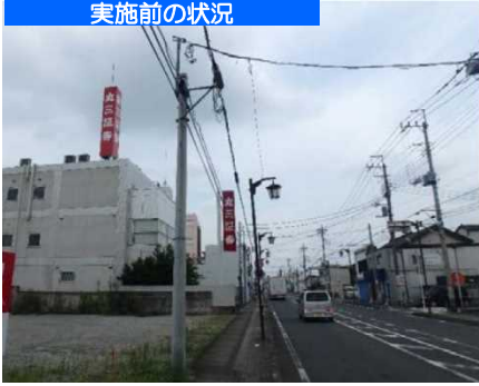
実施前の状況
