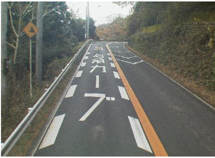
事業前の状況（現道）
