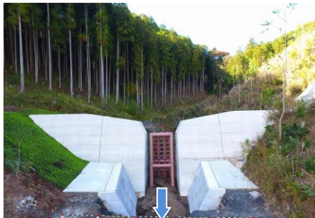
堰堤の完成状況
